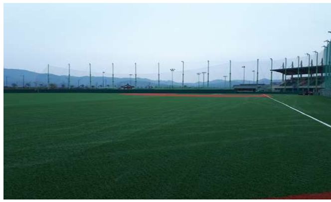
▶ 인조잔디 야구장 설치 완료
