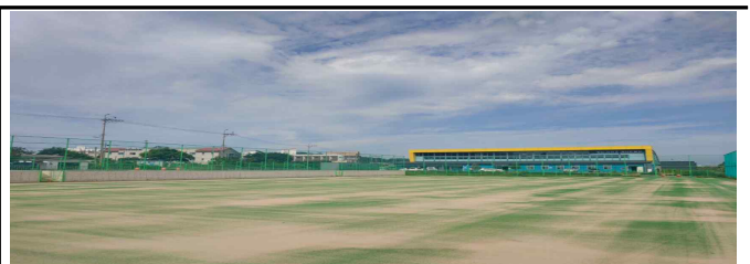
▶ 인조잔디 족구장 설치 완료
